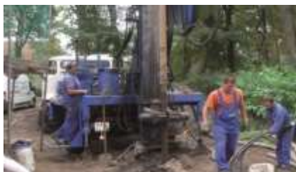
Tiefensonde - Einbau der Soleleitung
