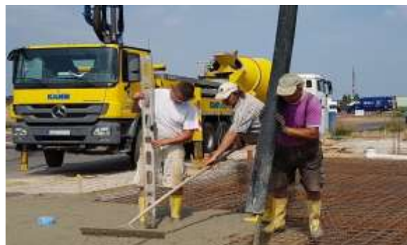
Mattenbewehrung und Betonage der Bodenplatte
