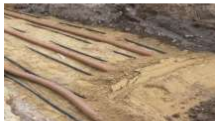
Flächenkollektor (Drainage optional)
