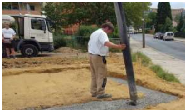
Betonage der Fundamente in Erdschalung
