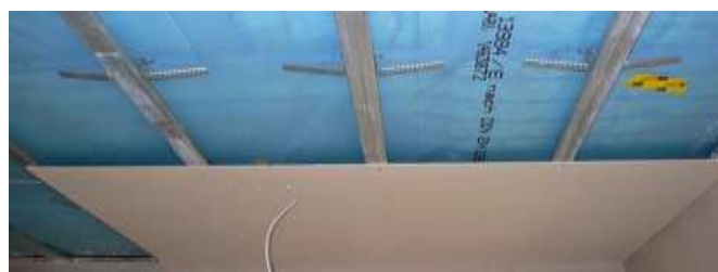
Dampfsperrfolie, Ausgleichsunterkonstruktion, Gipsbauplatte
