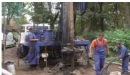
Tiefensonde - Einbau der Soleleitung
