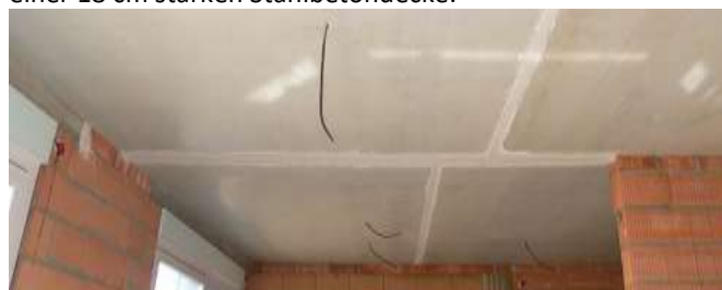
Die unteren Fugen der Beton-Filigrandecke werden geschlossen.
