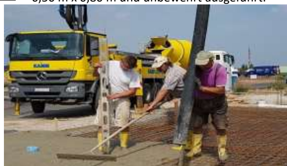
Mattenbewehrung und Betonage der Bodenplatte
