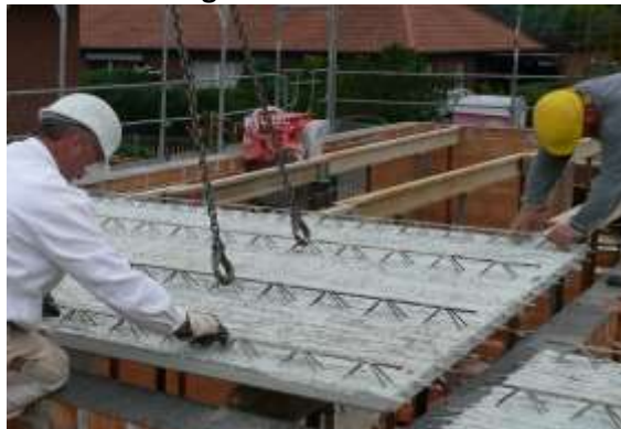
Verlegung der Filigrandeckenelemente
