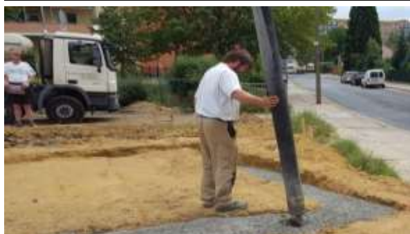
Betonage der Fundamente in Erdschalung
